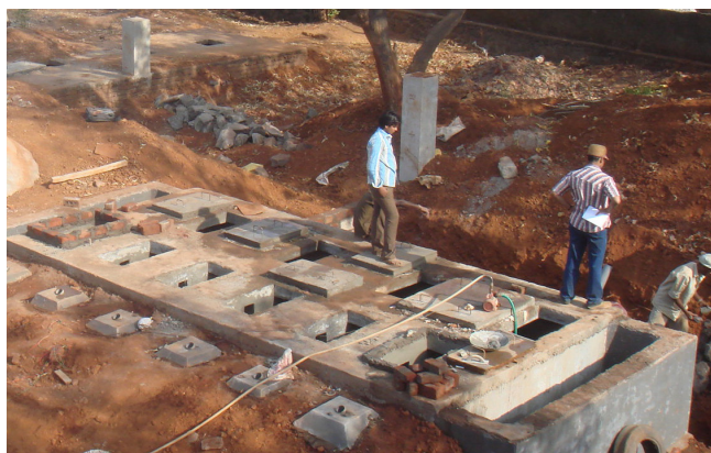
Servicios de empresas de construcción e ingeniería son fundamentales para el sector © Michael Kropac
