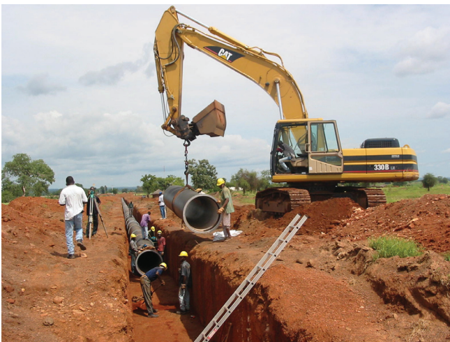
De grands travaux d'adduction d'eau ont été réalisés dans le cadre du projet Ziga
